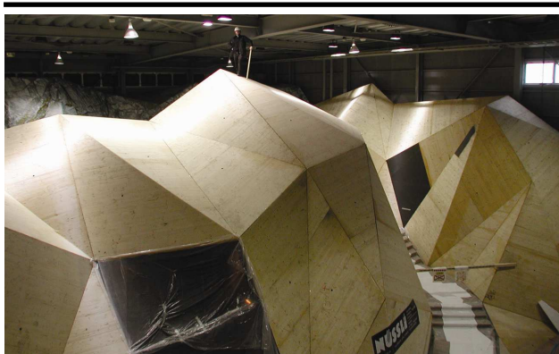
Holzkonstruktion des Bergs
