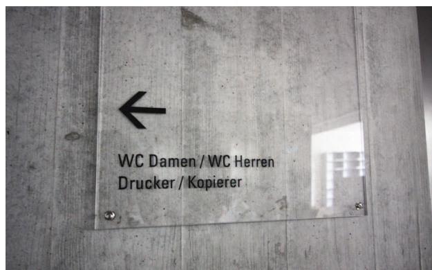
Orientierungsschild, Folie auf Plexiglas, direkt auf Sichtbeton befestigt
